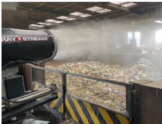
Traitement d'odeur - déchets
